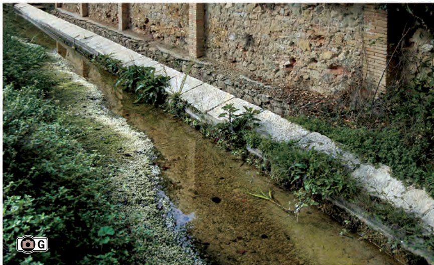
La Séquia Major del Vinalopó a l'alçada del llavador dels Clotets, 2008.
